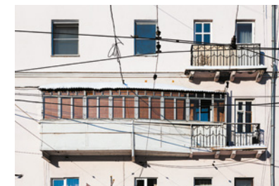
Пример изменения формы балкона, которая противоречит изначальному архитектурному облику здания
