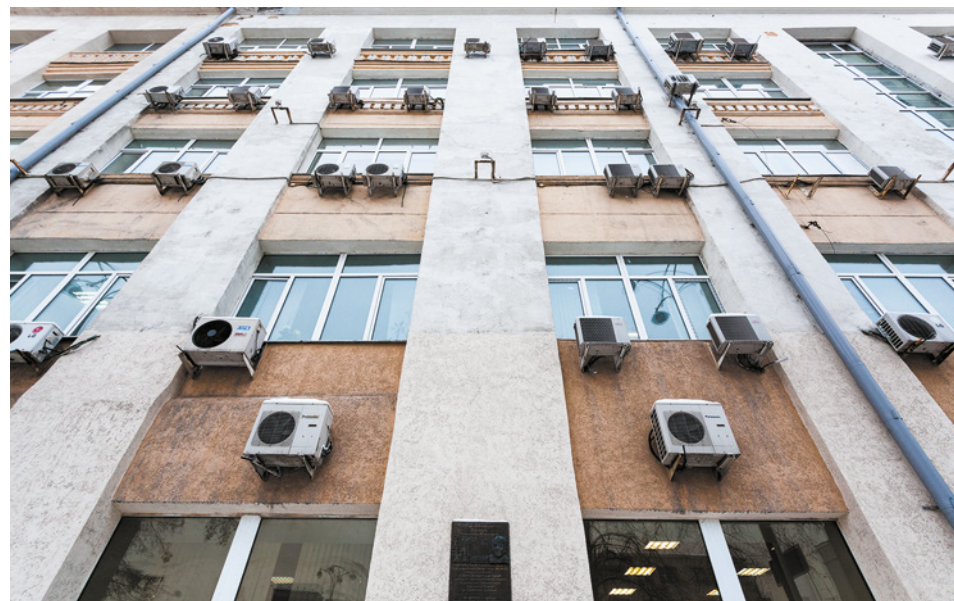
Пример неправильного размещения кондиционеров на фасаде здания
