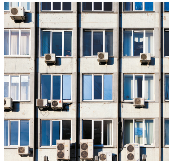
Пример неправильного размещения кондиционеров на фасаде здания
