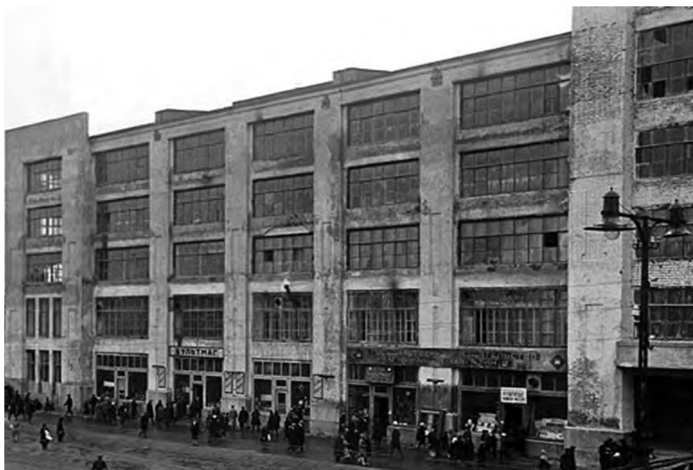
Рисунок 24. Здание торговых рядов на Площади имени 1905 года, 1931 г. (Источник: https://pastvu.com/p/303715 ). В правой части кадра зафиксированы характерные типы светильников с металлическим штампованным корпусом и лампами накаливания.
