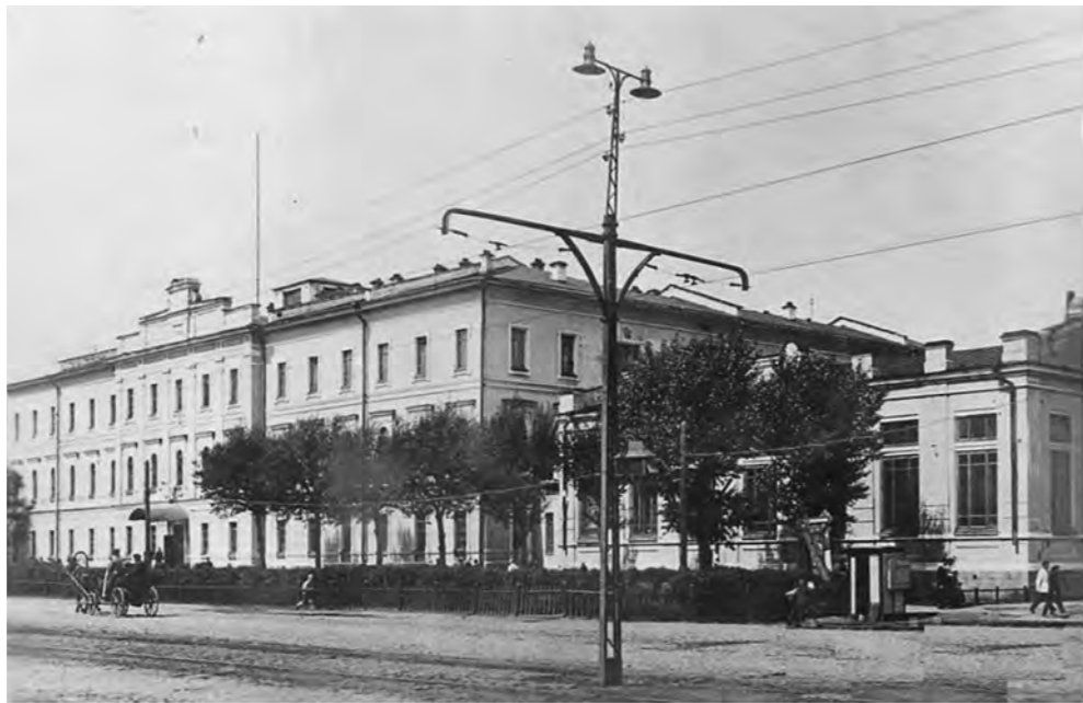
Рисунок 23. Опора контактной сети трамвая на проспекте Ленина, н. 1930-х гг. (Источник: https://pastvu.com/p/1104758 ). Опора выполнена из профилированного металлопроката на клепках и несет контактную сеть трамвая, сеть электропитания и светильники.
