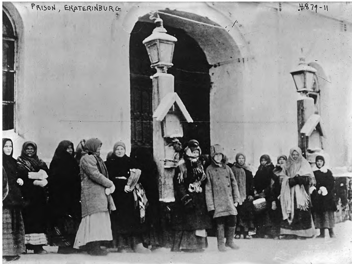
Рисунок 9. Ворота Екатеринбургского тюремного замка, 1900 – 10 гг. (Источник: https://pastvu.com/p/1187914 ). На четырехгранные деревянные столбы установлены квадратные в плане светильники с масляным источником света. В жестяной корпус, перекрытый вытяжным цилиндром, вставлены плоские стекла.
