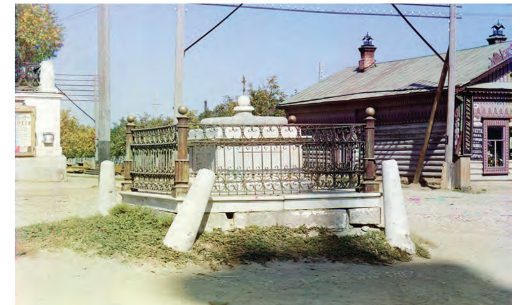
Рисунок 12. Место бывшего престола во временной полотнояной церкви Мушкетерского полка, 1909 г. (Источник: https://pastvu.com/p/298274 ). Значимая архитектурная форма размещена в пределах пешеходной зоны улицы, приподнята на основание в виде кладки из тесаных камней, ограждена узорной металлической оградой из литых и кованых элементов, окрашенных в зеленый цвет и массивными каменными боллардами.
