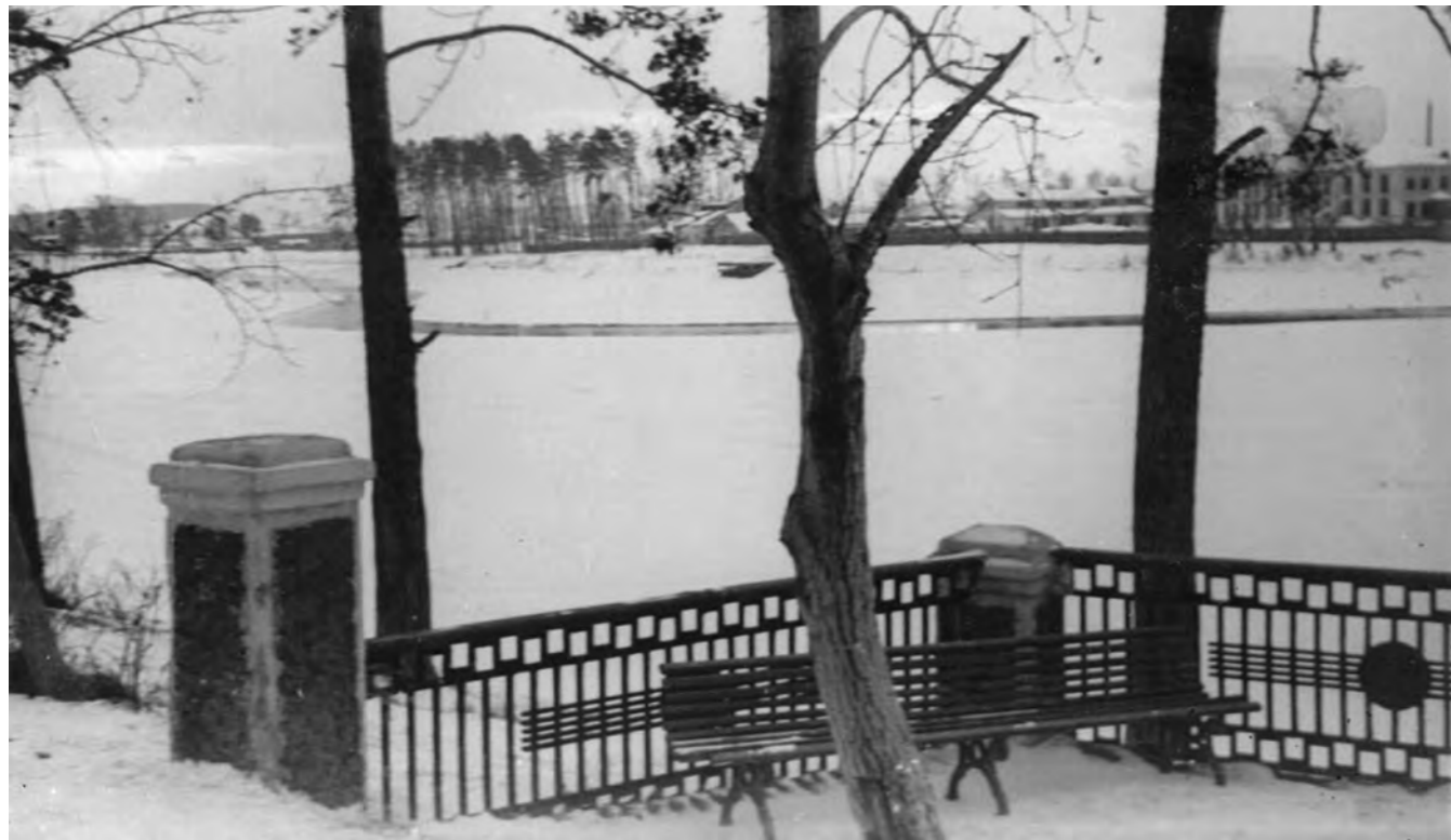
Рисунок 44. Уголок отдыха на берегу Исети в ЦПКУО, 1956 г. (Источник: https://pastvu.com/p/1111290 ). Применено типовое ограждение с секциями из литого чугуна. Массивные кирпичные столбы несколько несопоставлены решетке. Каркас скамейки также выполнен из литого чугуна. Сиденье выполнено из тонких деревянных реек по эргономичному профилю каркаса.
