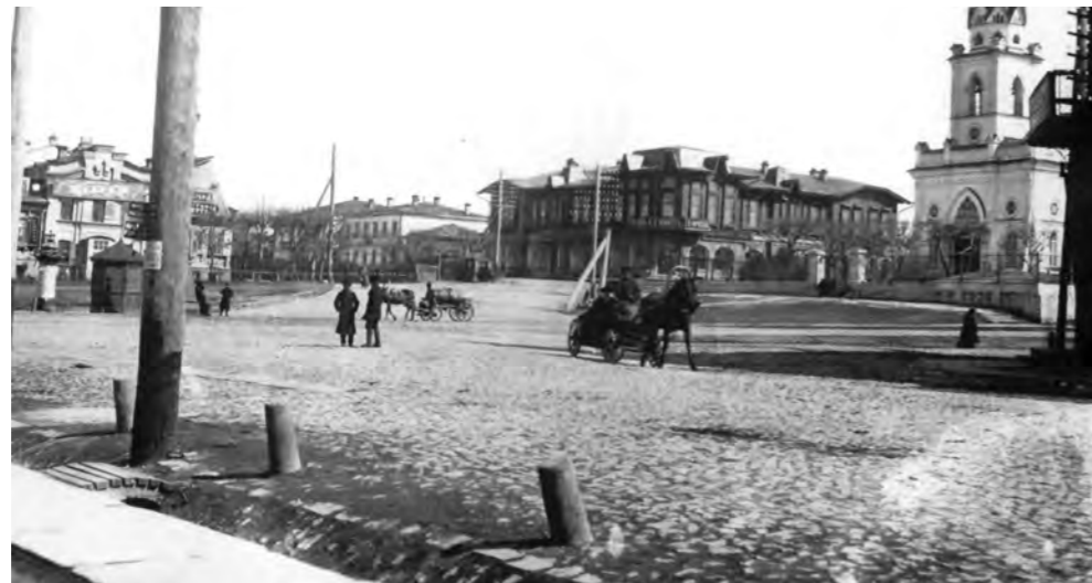
Рисунок 14. Магазин Штроля и костел Св. Анны на Покровском проспекте, 1910 – 12 гг. (Источник: https://pastvu.com/p/303661 ). Мостовая ограничена боллардами. Открытая траншея ливневой канализации имеет булыжное покрытие. Тропуар, покрытый каменными плитами соединен с мостовой небольшими мостками.
