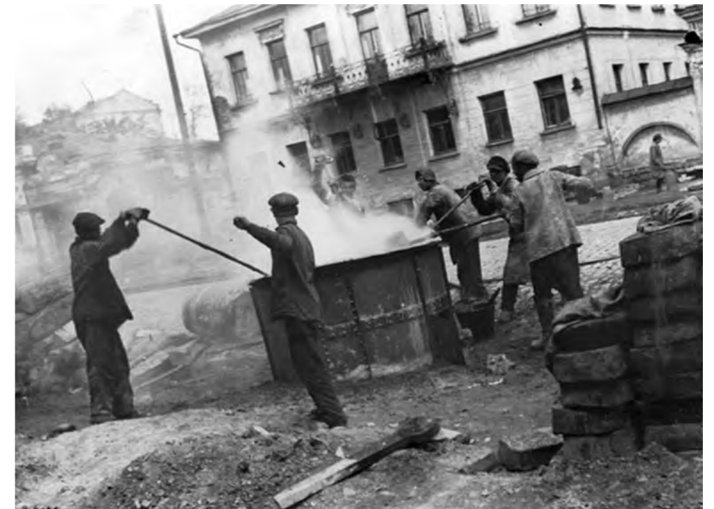
Рисунок 17. Улица Розы Люксембург, 1931 г. (Источник: https://pastvu.com/p/579604 ). Устройство асфальтового покрытия тротуара рядом с домом № 16. Проезжая часть покрыта брусчаткой. Каменные плиты разобранного тротуара сложены в стопки.
