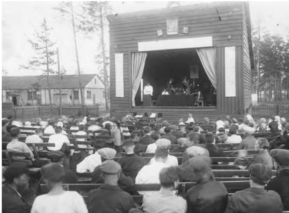
Рисунок 28. Эстрада в парке завода Уралэлектроаппарат, 1934 г. (Источник: https://pastvu.com/p/640658 ). Предельно простое по конструкции нестационарное некапитальное сооружение выполнено из пиломатериалов, украшено лозунгами и портретами. В оформлении сооружения использованы элементы и приемы, в большей степени характерные для помещений, а не для улиц - мебель, драпировки, цветы в горшках на столе. Скамейки зрительного зала выполнены из кругляка и стандартных пиломатериалов.
