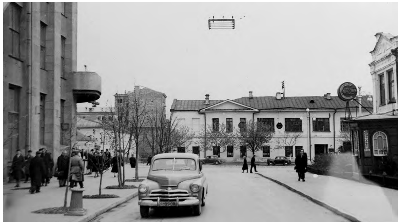
Рисунок 34. Вид из Театрального переулка на улицу 8 марта, 1958 г. (Источник: https://pastvu.com/p/350169 ). Для освещения улицы использован подвесной светильник с люминесцентными светильниками, незадолго до этого введенными в эксплуатацию в СССР. Урна выполнена в виде чугунной отливки, стилизованной под колонну классического ордера.
