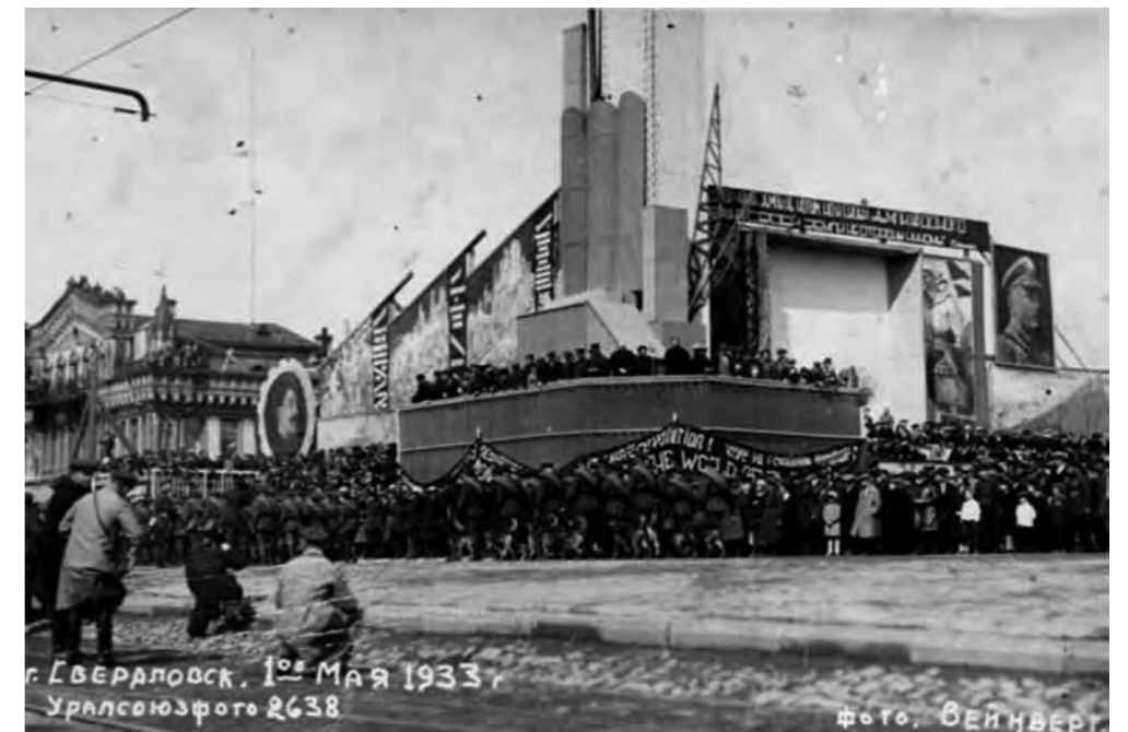
Рисунок 26. Первомайское оформление трибуны на Площади 1905 года, 1933 г. (Источник: https://pastvu.com/p/841177 ). Трибуна выполнена в характерных для стилистики конструктивизма супрематических и машинных формах, сочетаемых с шрифтовыми композициями и изображениями. Основной конструктивный материал — пило-материалы.
