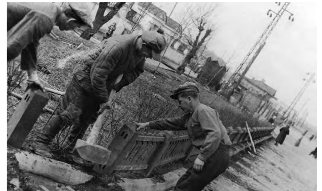
Рисунок 21. Благоустройство улицы Горького, 1934 г. (Источник: https://pastvu.com/p/808395 ). Деревянное ограждение газона в процессе монтажа. Для периода конструктивизма типичным было сочетание деревянной ограды и линейно посаженного кустарника по краю газона.
