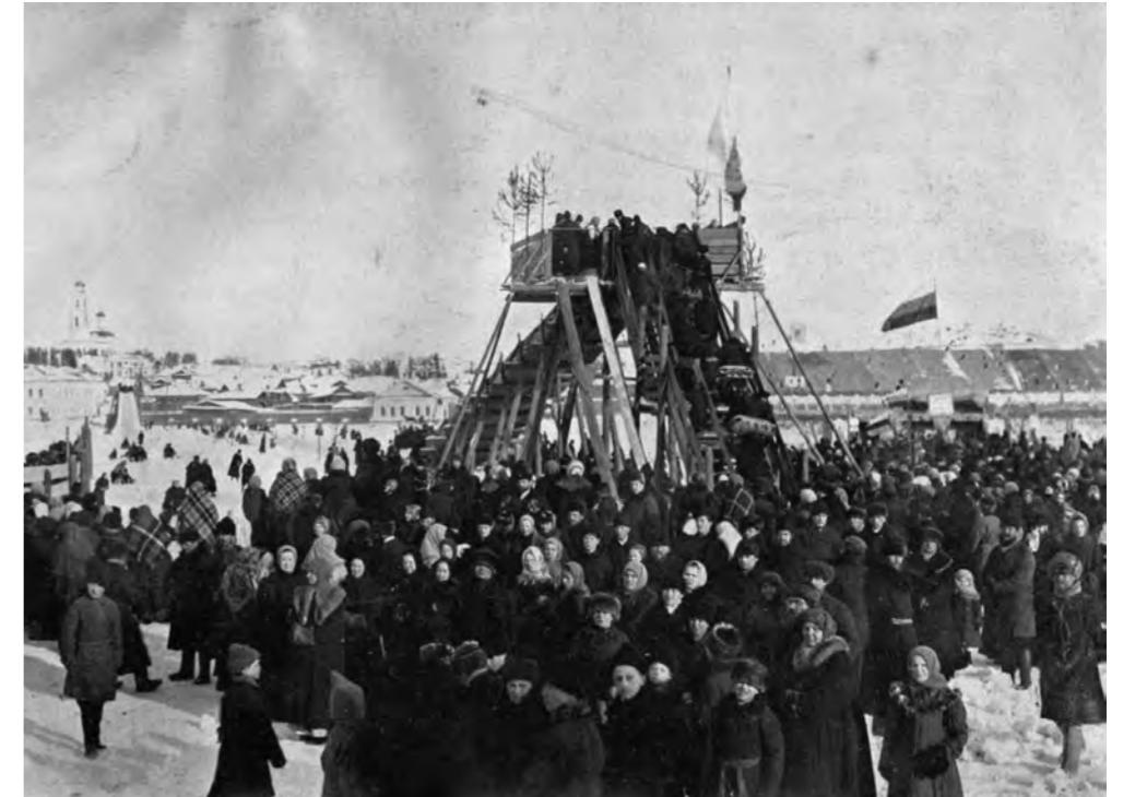
Рисунок 11. Катание с горки во время масленичных гуляний на Городском пруду, 1900 – 09 гг. (Источник: https://pastvu.com/p/1113205 ). Горка имеет специфическую конструкцию каркаса с наклонными парами стоек из кругляка.
