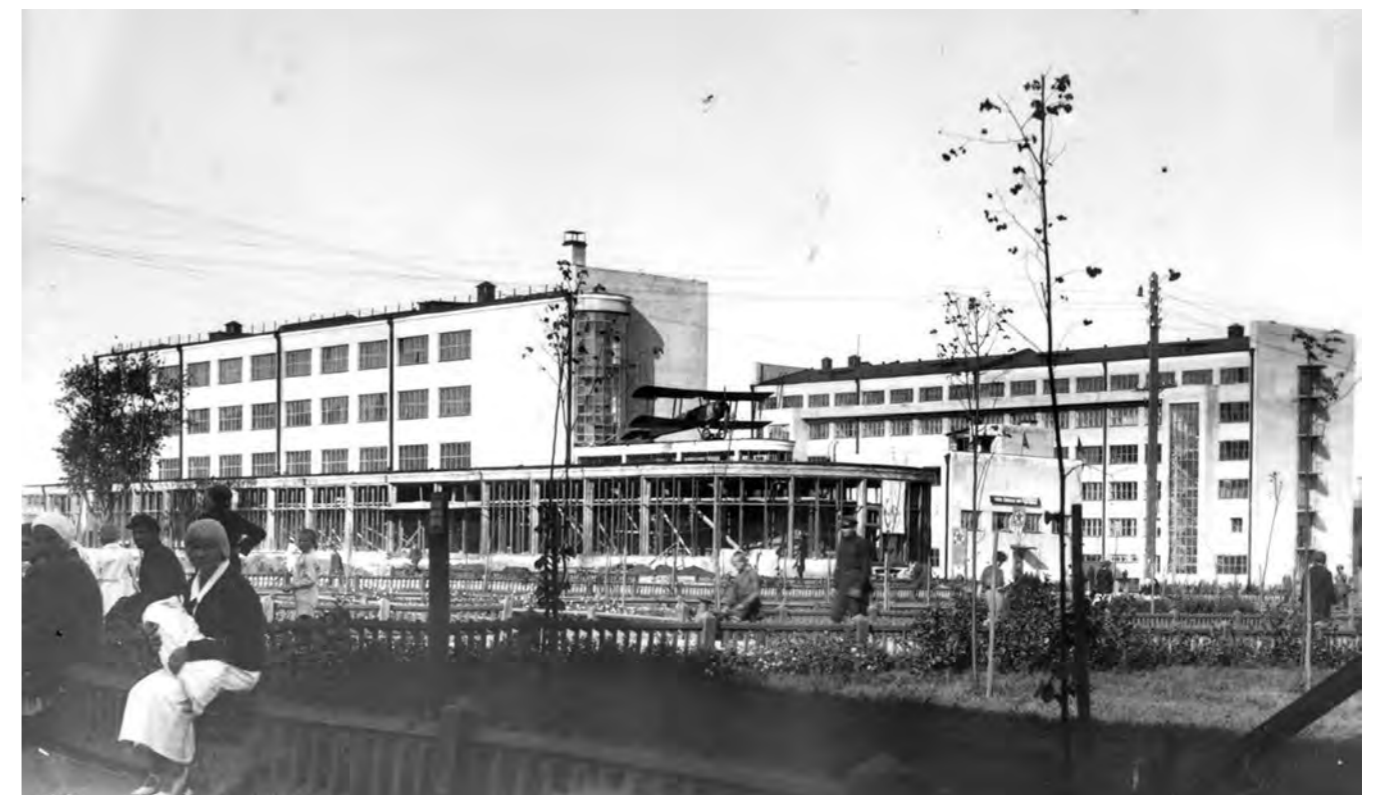
Рисунок 22. Благоустройство улицы Малышева перед строящимся Домом Обороны, 1934 г. (Источник: https://pastvu.com/p/307886 ). На переднем плане характерное для конца 20 - начала 30-х гг. Ограждение газона, выполненное из пиломатериалов. Вследствие ненадежной конструкции и использования не по назначению это ограждение быстро разрушалось. Поддерживающие конструкции для молодых деревьев, расположенных на газоне, предельно упрощены.
